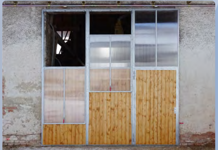
Schiebetor mit Schiebefenstern
