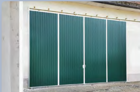
Schiebetor mit Blechfüllung
