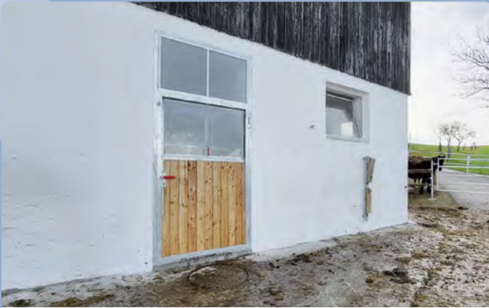
Tür mit eingebautem Schiebefenster
