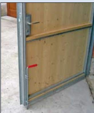
Torflügel mit Verschlussriegel und einwandiger Holzfüllung.
