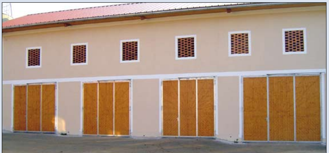
Falttorverschluss mit kompakten Treibriegeln, Füllung mit abwaschbarem Betoplan.
