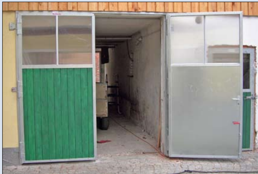
Flügeltor mit kombinierter Füllung - außen Holz, innen Blech verzinkt.
