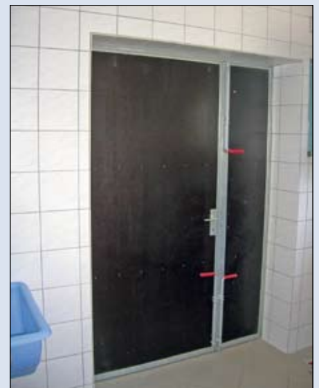
2-flügelige Tür mit asymmetrischen Flügeln. Verschlussriegel mit speziellem Exzenterverschluss zum Fixieren der Torflügel in geöffneter und geschlossener Stellung. Griffe mit Kunststoffüberzug.
