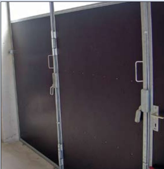
Falttorverschluss mit kompakten Treibriegeln, Füllung mit abwaschbarem Betoplan.
